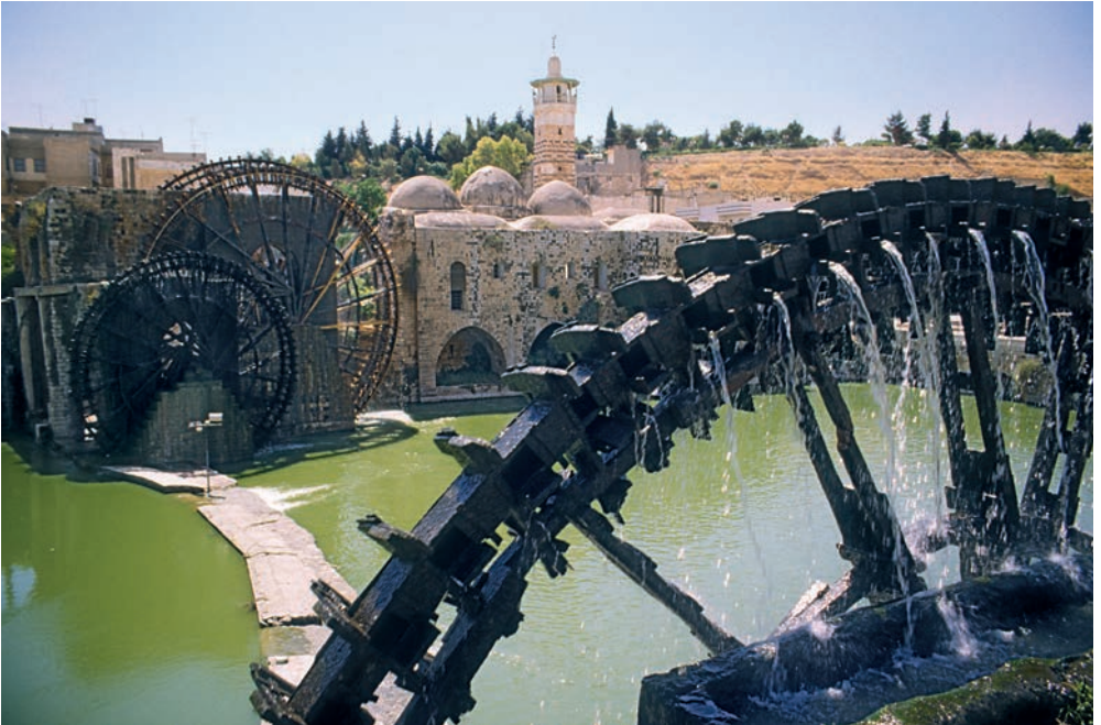
10 In Hama laufen noch Schöpfräder, die früher die Feldbewässerung und Trinkwasserversorgung gewährleisteten.
