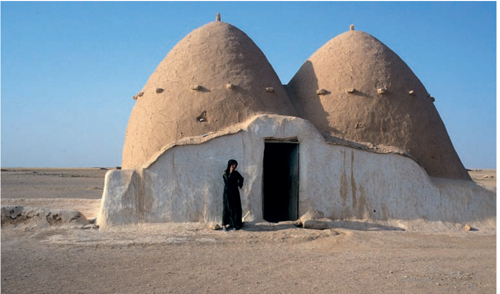
8 Kuppelhaus aus Lehmziegeln – eine traditionelle Bauweise, die dem ariden Klima perfekt angepasst ist.
